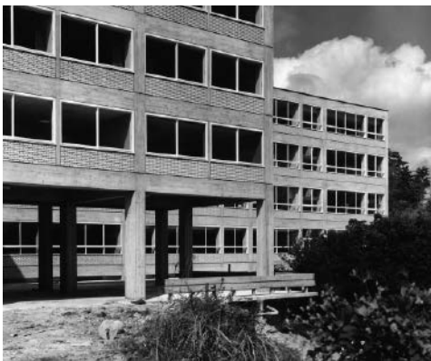
図10 第4学舎1号館の傾斜へ張り出す床面
