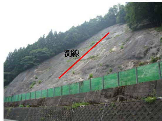
図-2 吹付け法面（A地区）
