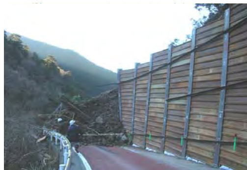
写真-1 崩壊後の状況
