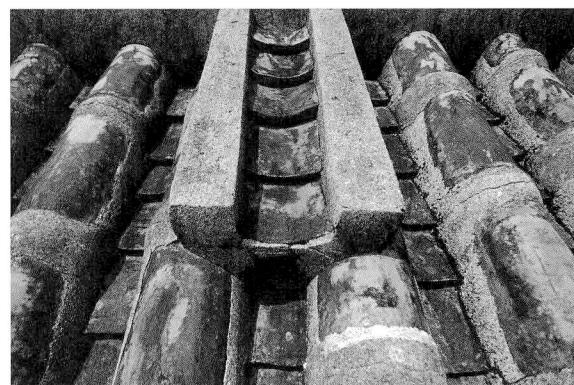
写真2 沖縄・中村家住宅の換気口（空気抜）
