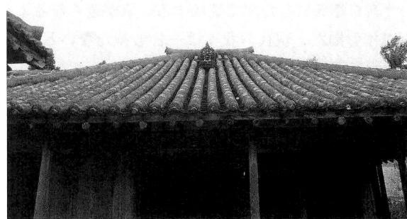
写真1 沖縄・中村家住宅の瓦屋根、男瓦（丸瓦）と女瓦（平瓦）のみで葺かれている。
