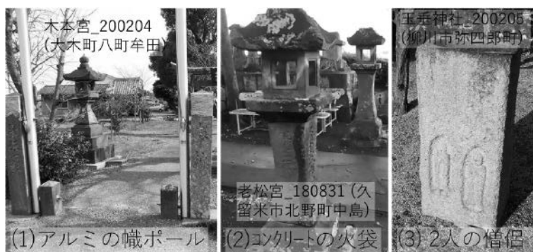
写真3 材の風化と対応例
